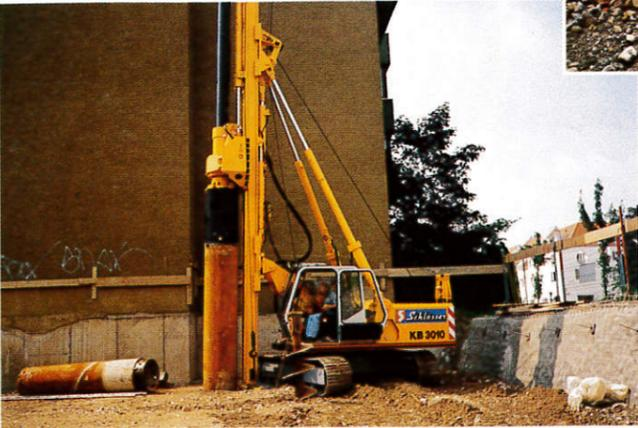
Eindreuen der Bohrrohre von 750 mm Ø mit H 90-Getriebe und Drehteller.
