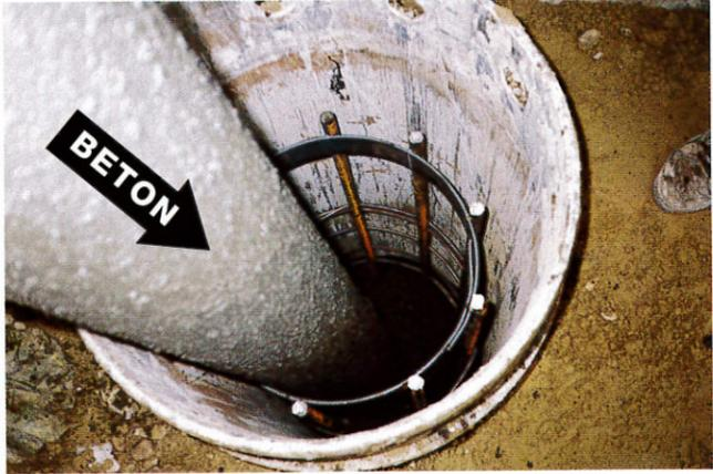
Betonierung einer Pfahlbohrung mit eingebrachtem Bewehrungskäfig.
