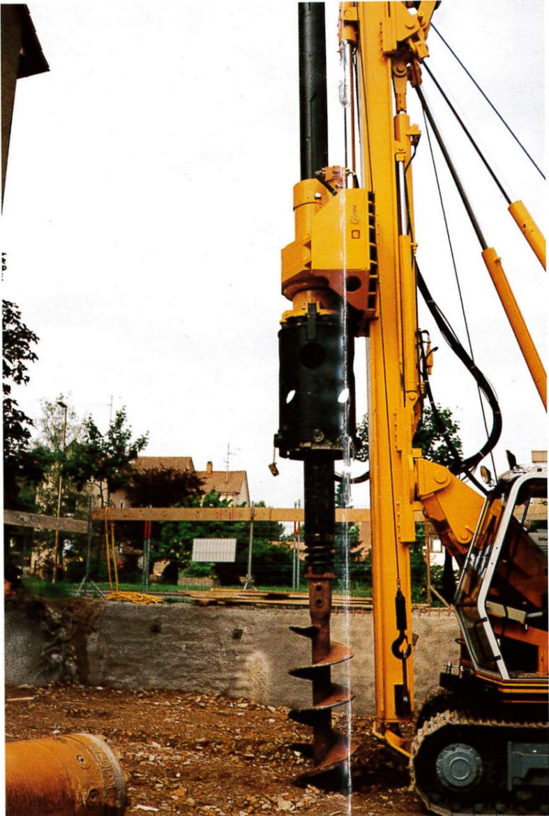
Das sehr flache Drehgetriebe (H 90) mit geringer Spitzenhöhe macht Verrohrungsarbeiten an der Wand möglich.
