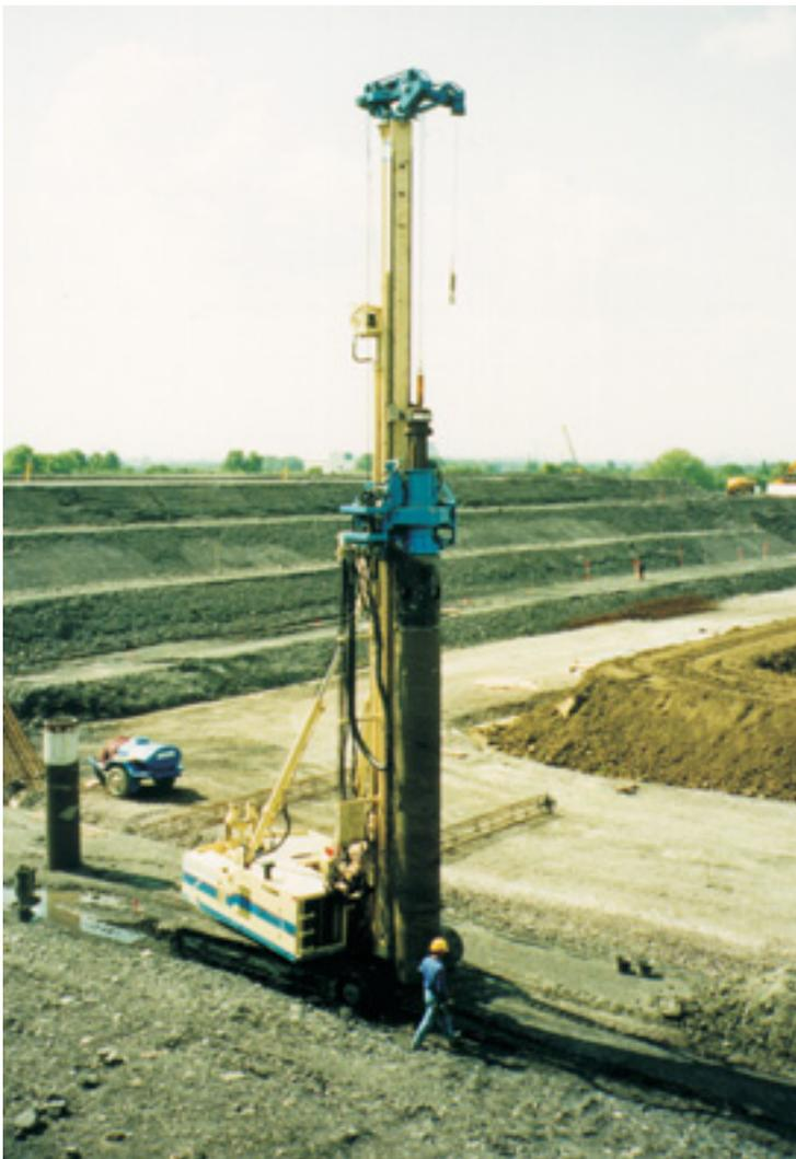
**KB 3010 mit Drehantrieb Typ KH 90**
